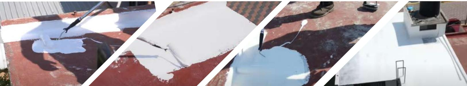
**Tip:** Es importante que antes de poner una capa completa de malla se reparen juntas constructivas o algún elemento que requiera atención a detalle.
